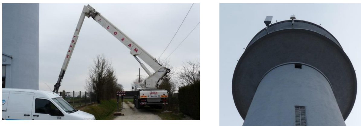
Figure 82 : Installation d'un réémetteur sur un château d'eau
